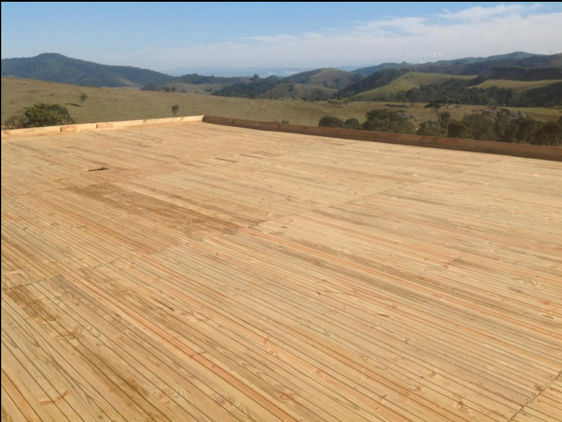
Base telhado do verde
